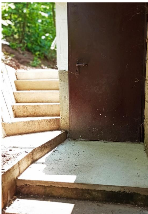
Die neue Treppe
